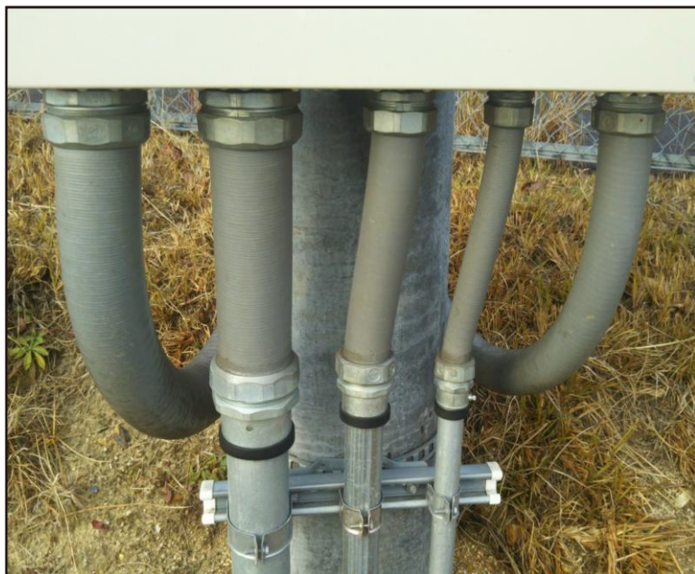
防水プリカチューブ用 防水型ボックスコネクタ & 防水型ねじなしユニオンカップリング
