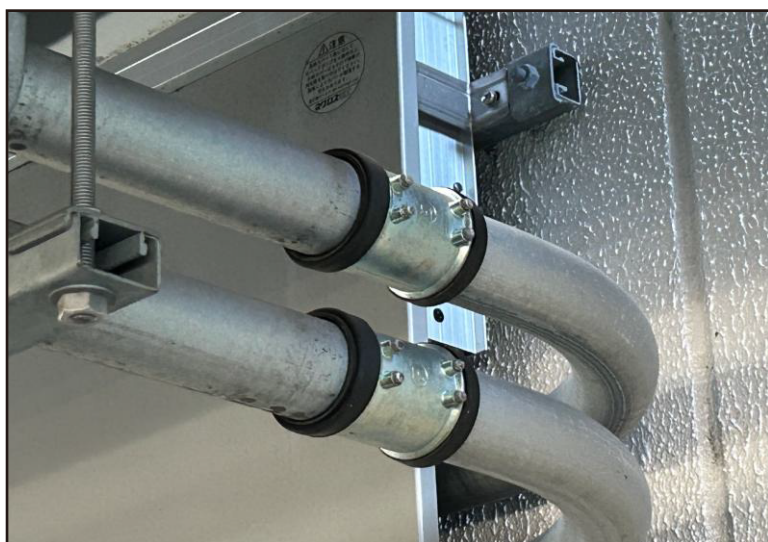
金属製電線管用 防水型ねじなしカップリング (新型タイプ)
