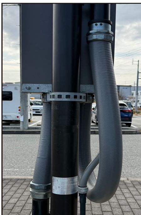
防水プリカチューブ用 防水型ユニオンボックスコネクタ & 防水型ねじなし ユニオンカップリング & 防水型ユニオンカップリング
